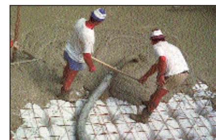
Φώτο 5. Με το Cuporex προχωρεί η γέμιση, χωρίς τη χρονοβόρα διαδικασία επιχωμάτωσης και καλουπιών.
