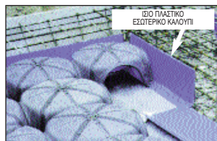
Φώτο 4. Συνδυασμός καλουπιών θεμελίωσης με Cuporex και ίσιο πλαστικό εσωτερικό καλούπι που δεν αφαιρείται μετά την γέμιση.
