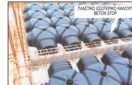
Φώτο 3. Συνδυασμός καλουπιών θεμελίωσης Cuporex και πλαστικό εσωτερικό καλούπι (Beton Stop), που είναι ρυθμιζόμενο και δεν αφαιρείται μετά την γέμιση.
