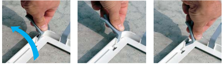
Insertion de clipsage de pattes de scellement Pictorial sequence of pivots laying over the frame Secuencia fotografica de puesta de la ancla sobre el marco
